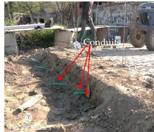
INSTALLATION OF CONDUITS
